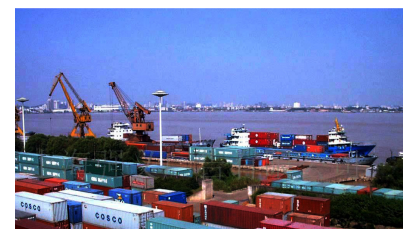
Saigon Premier Container Terminal, Vietnam
